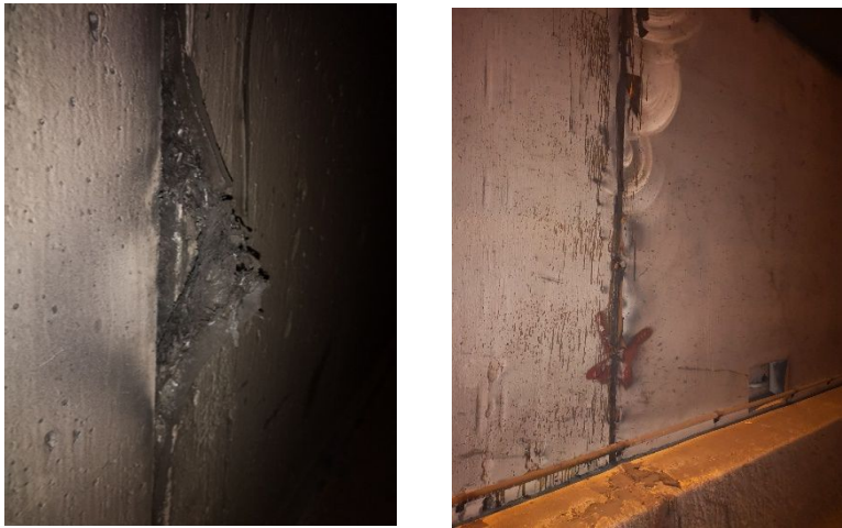
Figure 6 : Fond de joint en élastomère tressé (zone de voile latéral non revêtu)
