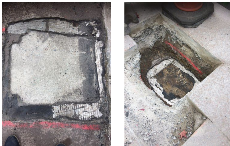
Figure 7 : Remise en état de fouilles d'investigation EIFFAGE ROUTE/STRUCTUREO
